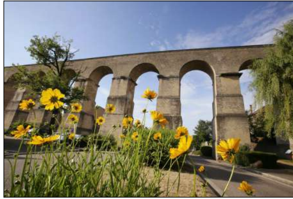
Aqueduc de Jouy-aux-Arches, II e siècle — Moselle
